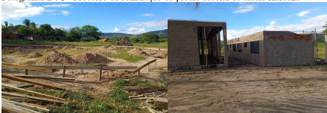
Fotografias 2 e 3 - Processo da construção do prédio escolar da aldeia Karuazú
