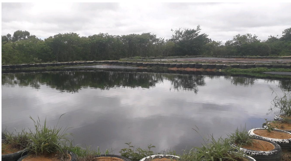
Figura 3: Lagoa de tratamento com chorume em sua cota máxima
