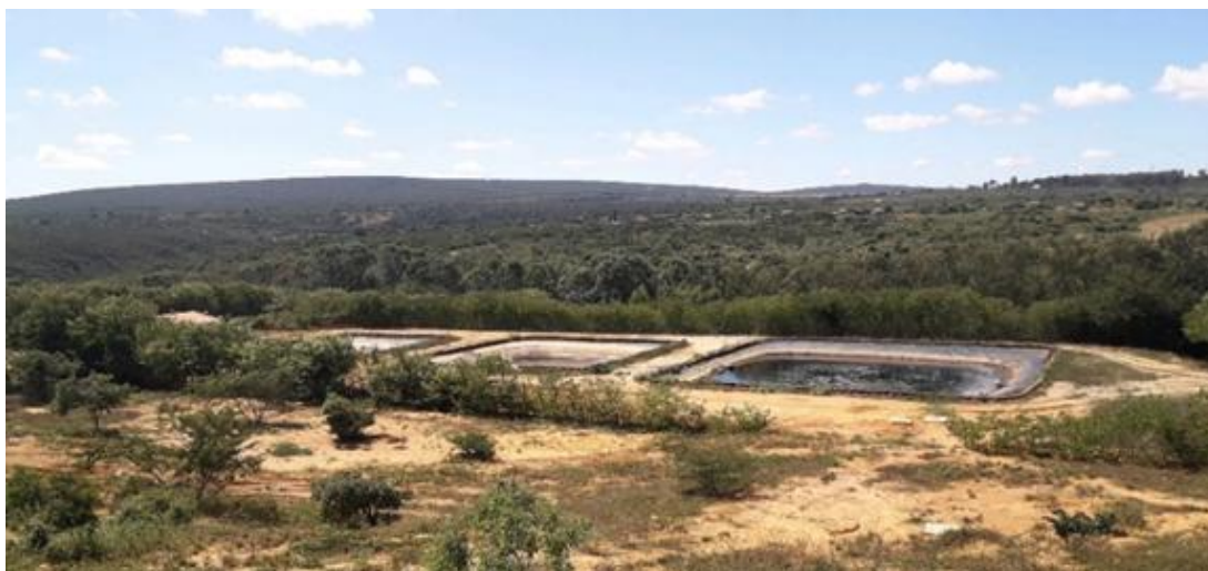
Figura 1: Lagoas de tratamento de chorume
