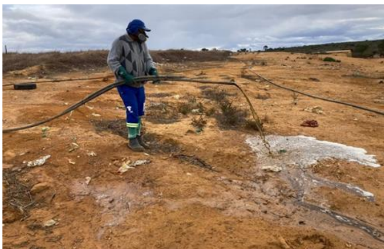
Figura 2: Processo de recirculação de chorume sendo executado
