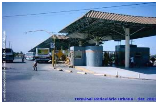
Figura 6. Terminal rodoviário urbano do Benedito Bentes. Fonte: Autores (2009).
