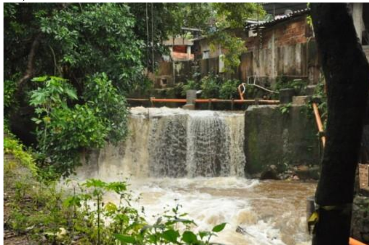
Figura 3: Construções irregulares na área do Jardim Botânico Fonte: Portal Implicante (2012)
