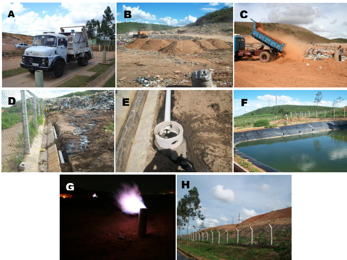
Figura 2. Tratamento do lixo recolhido pelo município de Arapiraca - AL. Pesagem dos caminhões de lixo (A); Conformação, compactação e cobertura dos resíduos (B - C); Drenagem do chorume (D - E); Lagoas de tratamento (F); Transformação do metano ( \text{CH}_4 ) em dióxido de carbono ( \text{CO}_2 ) através da queima do gás (G); Vista das camadas dos resíduos totalmente cobertos (H). Fonte: Secretaria Municipal de Meio Ambiente e Saneamento de Arapiraca - AL.
